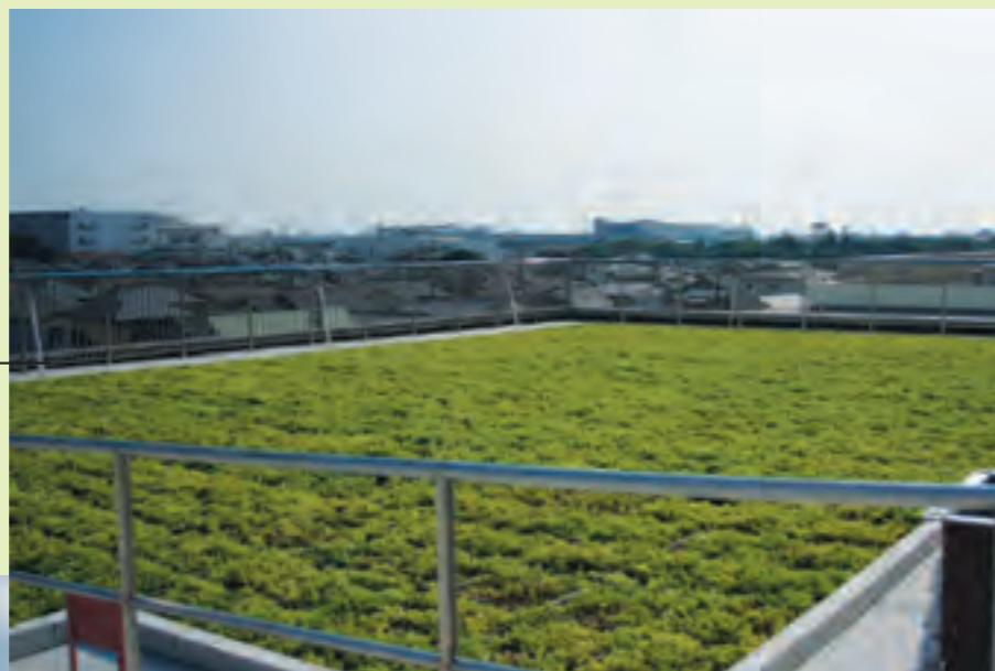
緑に覆われる福祉施設の屋上
