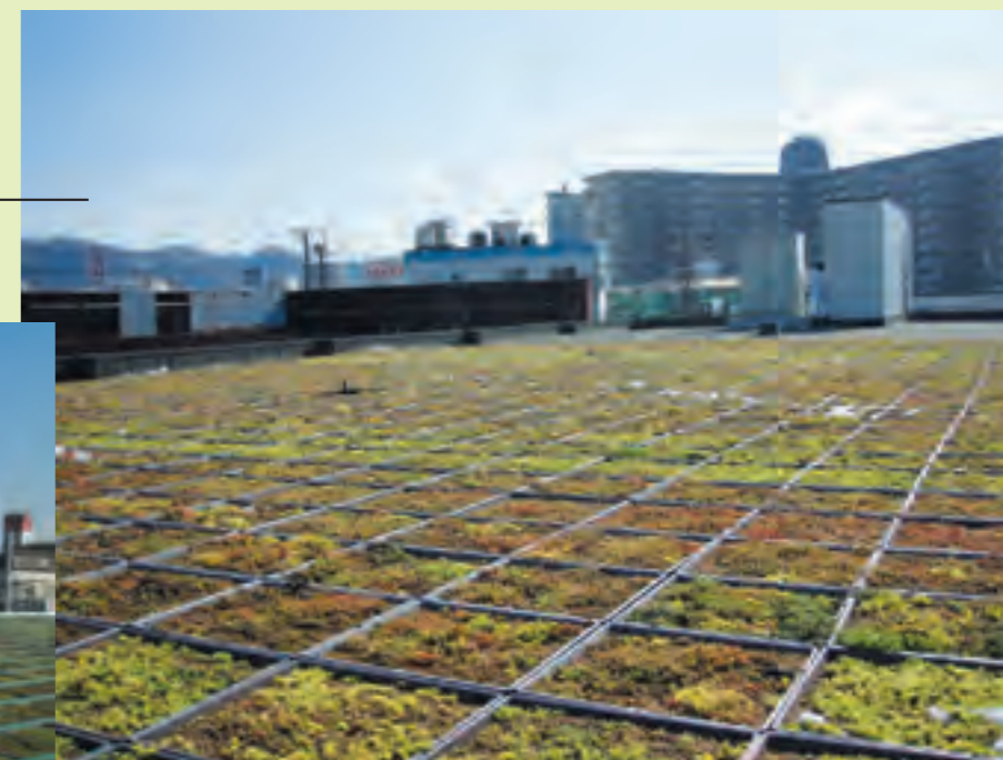
街中の産業施設の広大な屋上も緑地に変身
